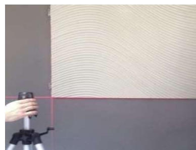
Закрепить панель на стене
