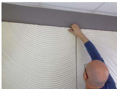
Пластины следующей панели заводятся за уже установленную
