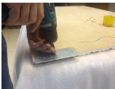
Закрепить пластины на панель с помощью саморезов
