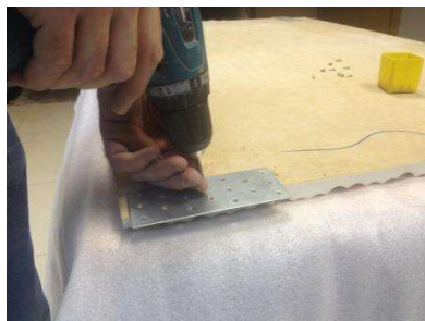
Закрепить пластины на панель с помощью саморезов
