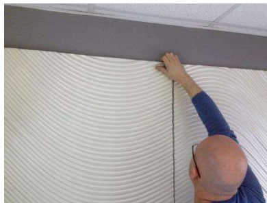
Пластины следующей панели заводятся за уже установленную
